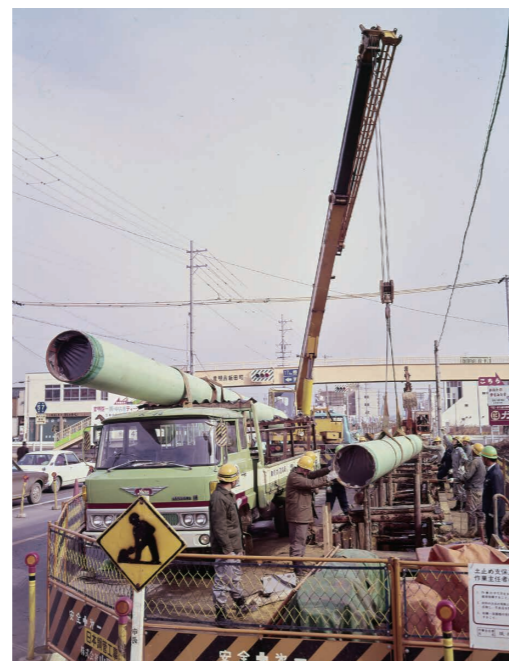
輸送幹線の建設工事(豊明市内)
