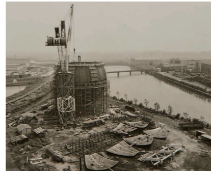
球型ホルダーを建設中の上野工場
